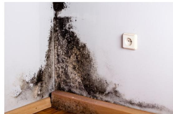
Schimmelbefall durch schlechtes Lüften nach Fensterisolierung
